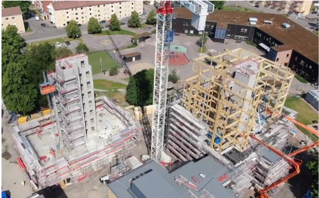
Figur 6. Bild på Hagaborg projektet under uppbyggnad. (NCC)
